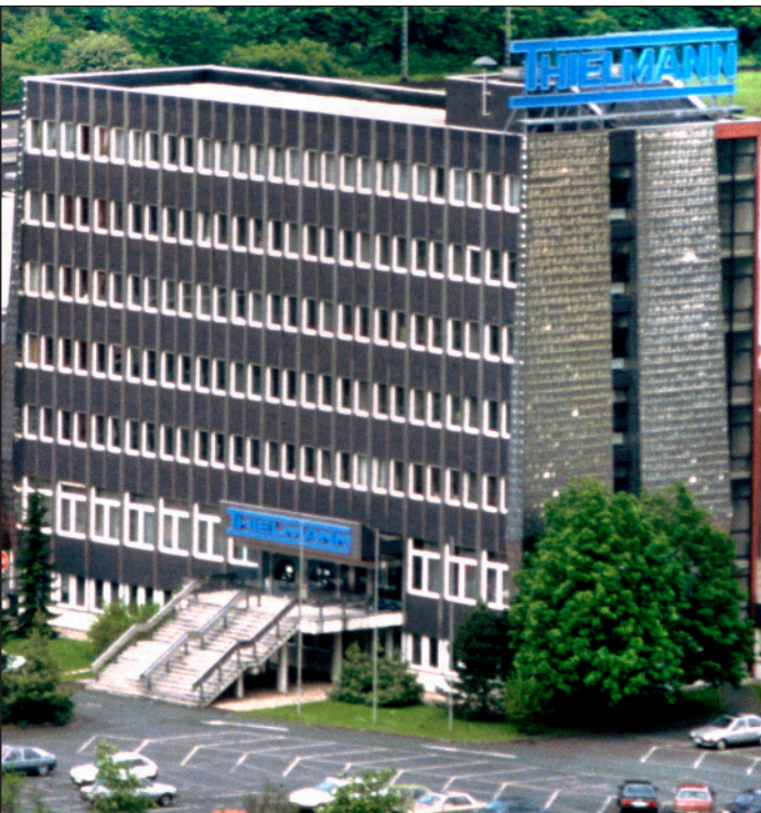
Die Sechsheldener Thielmann-Zentrale vor dem Bau des großen Parkdecks und mit typischem Firmen-Schriftzug.
